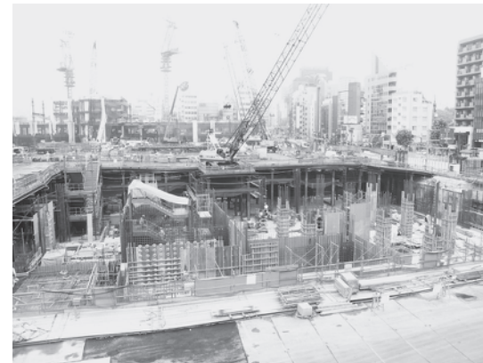
東京ミッドタウン工事現場（2005年）
