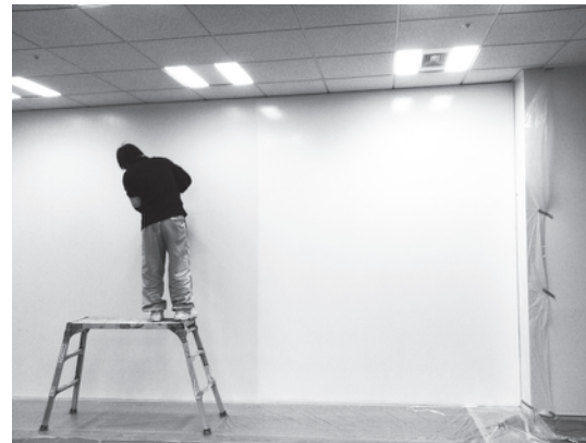
デザイン・ラウンジ工事中の様子(2012年)
